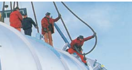
▲ Auch hier ist Teamarbeit gefragt: Ein 130 Tonnen schwerer Jumboerhitzer wird verladen.
